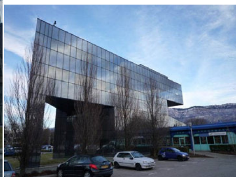
Façade ouest du bâtiment de l'horloge
