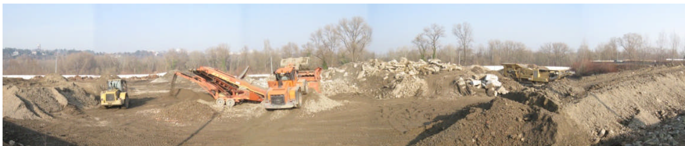
Pré traitement sur site
