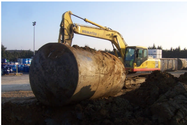
Dégazage des cuves semi enterrées Excavation des cuves
