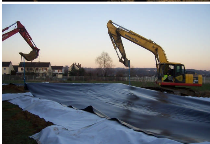
Excavation des matériaux encaissants Préparation aire de stockage temporaire
