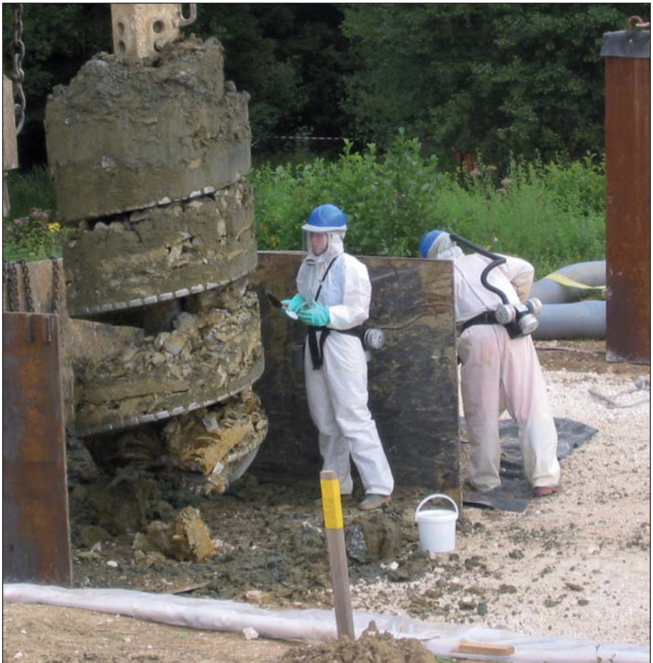
Figure 2: Suivi des travaux de mise en place des pieux de fondation de la halle d'excavation: les matériaux sont triés puis évacués en fonction de leur degré de contamination sur la base des résultats d'analyses réalisées sur les échantillons prélevés.
